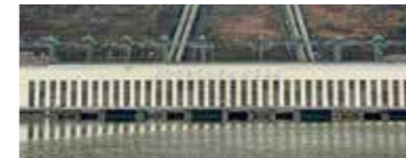
1930 Inbetriebnahme Pumpspeicher-Kraftwerk Herdecke – »Koepchenwerk«
