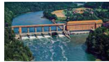
1920 Inbetriebnahme Lauf-Kraftwerk Eglisau (CH) mit sieben Turbinen und maximal 32,5 MW
