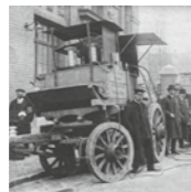
1909 Einsatz eines Kabelprüfwagens der Firma F & G
