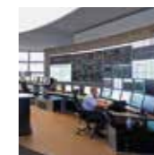
2009 Eröffnung der neuen Schaltzentrale »Power Grid Control« in Wien-Unterlaa, Verbund-Austrian Power Grid AG
