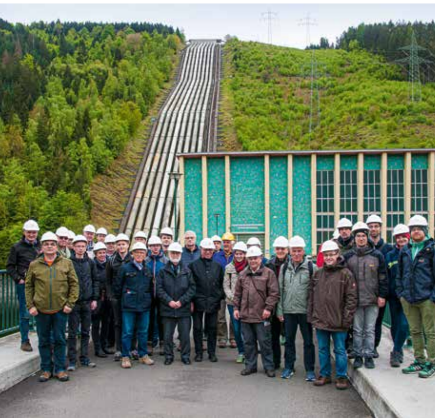
Krafthaus des PSW Hohenwarte II mit acht Stück Hang-Rohr-Leitungen – und wir auf dem Besuchsweg
