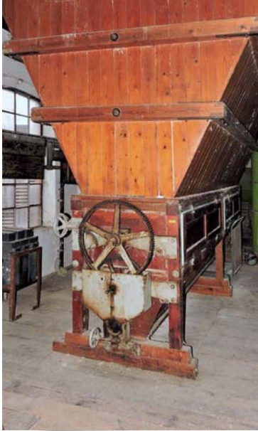
Durch die oberen Stockwerke der Mühle erstrecken sich große Speicher für das Mehl. BILD LINKS
